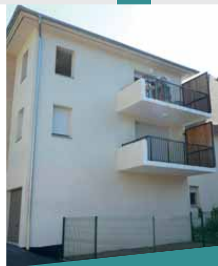
Logements sociaux réalisés dans le centre-bourg en 2015.
