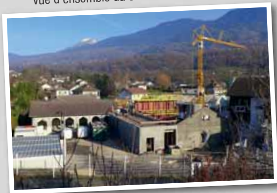
Vue d'ensemble du chantier mi-décembre
