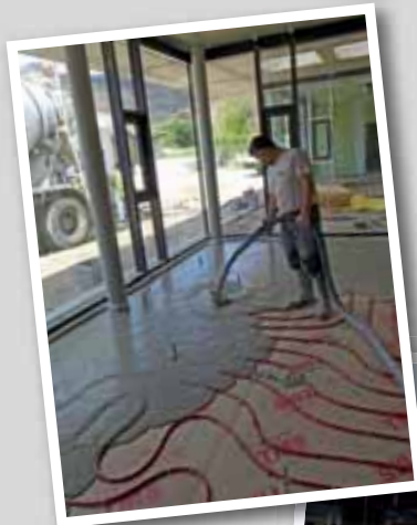
Réalisation du chauffage par le sol
