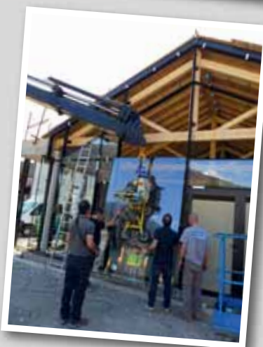
Mise en place du vitrage au centre de loisirs
