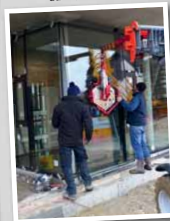
Mise en place des vitres du multi-accueil
