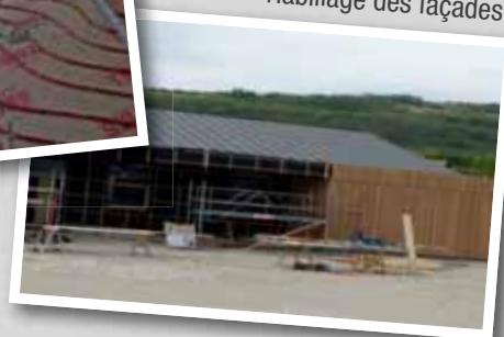
Habillage des façades
