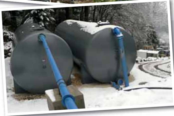
Fin de chantier novembre 2015 .
