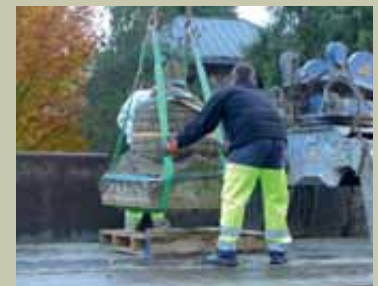
Sauvetage d'un chapiteau avec boule et pomme de pin pour un futur moulage.
