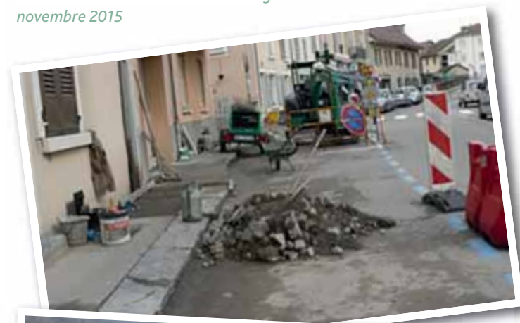
Travaux en cours dans le centre Bourg novembre 2015
