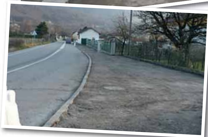
Travaux en cours devant « chez Marie » décembre 2015
