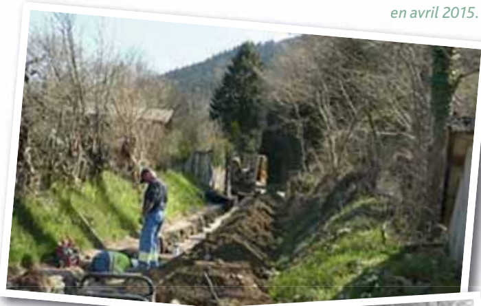
Chantier au Fugearet en avril 2015.
