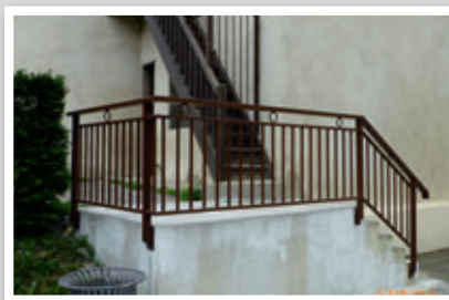
Remplacement d'une rambarde située à l'arrière de l'église suite à des dégradations.
