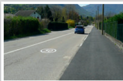
Réfection de trottoirs et cheminements piétons.
