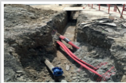
Modernisation du réseau d'eau potable sur le secteur des Alberges par la Métro (travaux jusqu'à mi-juillet).
