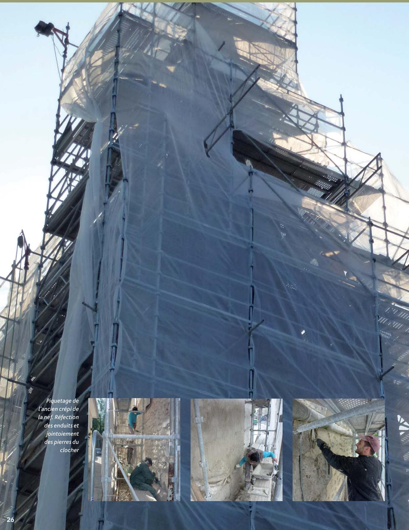
*Piquetage de l'ancien crépi de la nef. Réfection des enduits et jointoiement des pierres du clocher*
