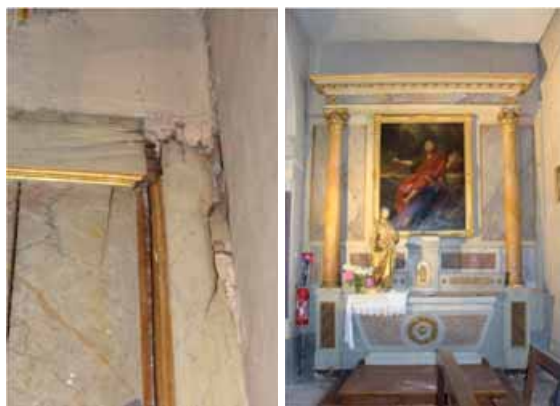
A gauche le montant droit avant réparation, à droite la restauration terminée.
