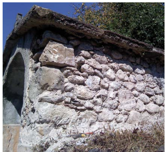
L'ancien enduit est enlevé pour la réfection des joints, avant l'application d'un crépi à la chaux.
