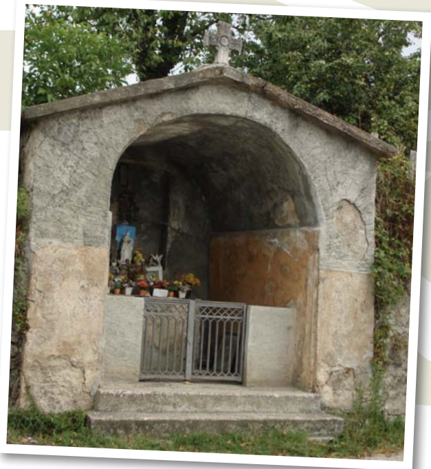
A gauche l'oratoire dans les années 1950, déjà très détérioré. A droite tel que nous pouvions le voir il y a encore quelques mois. Les enduits ciment empêchaient les murs de « respirer », une grille provenant sans doute de l'église du village avait remplacé celle d'origine.
