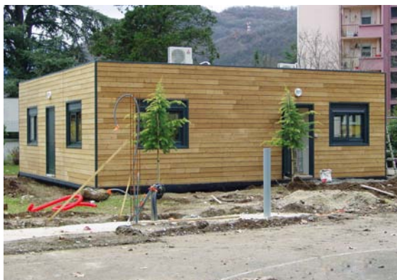
Le chantier de la nouvelle maison médicale
