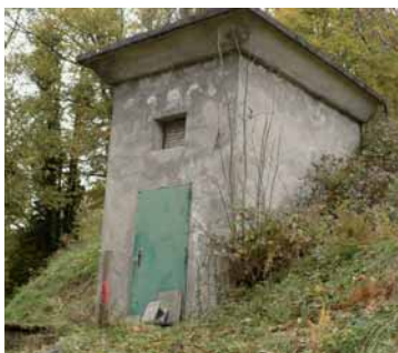
Pierre Rousse avant travaux
