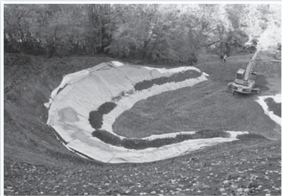
Les travaux de confortement
