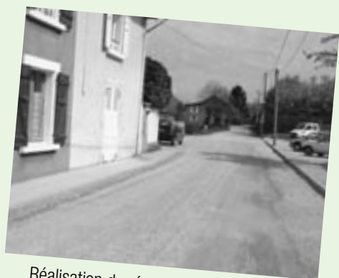
Réalisation du réseau d'assainissement entre le carrefour de la Chapelle et le chemin de la Croze.
