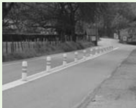
Avant le chemin des Combes
