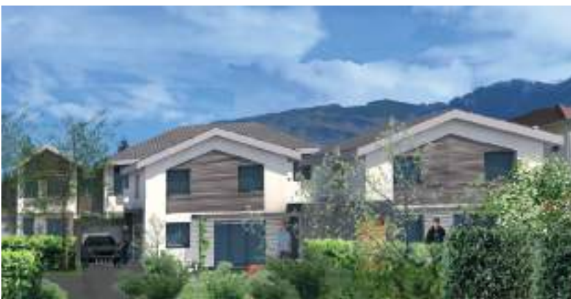
« Les Jardins d'Ysaline » avec ses 4 villas et son bâtiment collectif de 6 logements
